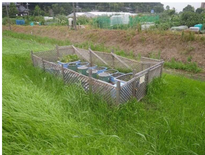
図 2-8 木製フェンス設置状況
